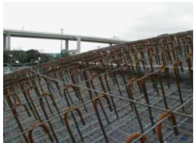
写真-1 コンクリート垂れ防止金網設置状況
