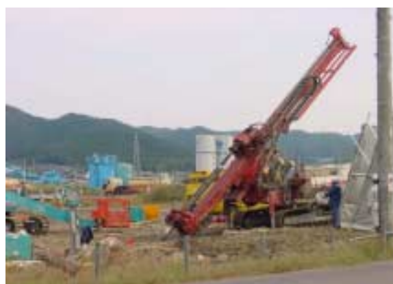
写真-3 斜杭 45 度の削孔試験状況
