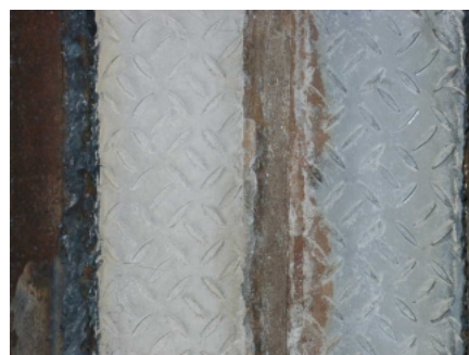
写真-3 モルタルの充填状況
