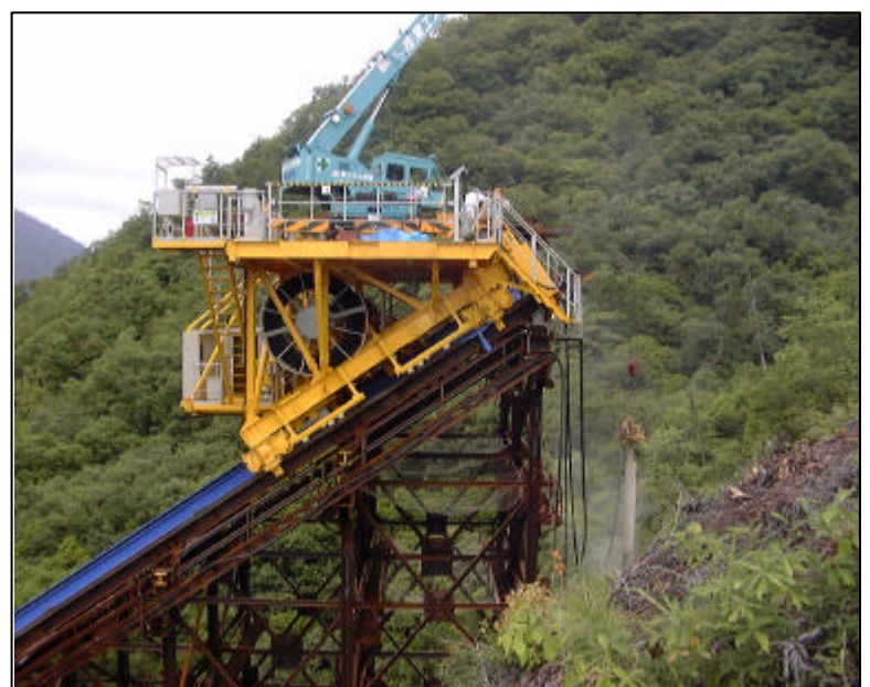
写真-1 ダウンザホールハンマーによる削孔状況
