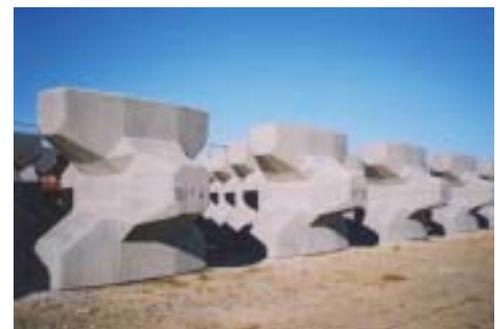
写真-1 実施工後の消波ブロック
