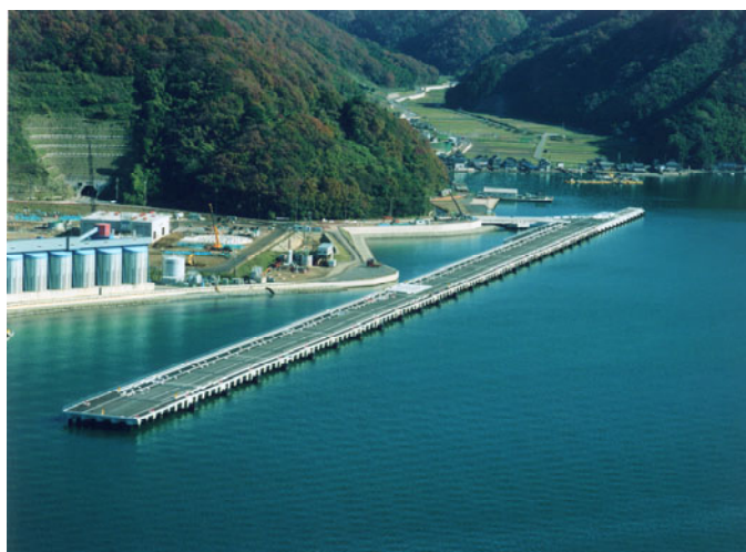
写真-1 揚炭棧橋全景
