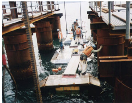
写真-3 杭間への引き込み状況
