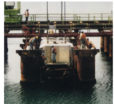
写真-4 TSM-W 吊り上げ状況
