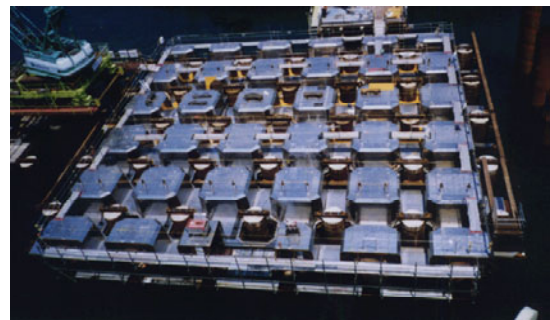
写真-5 TSM-W 吊り上げ状況
