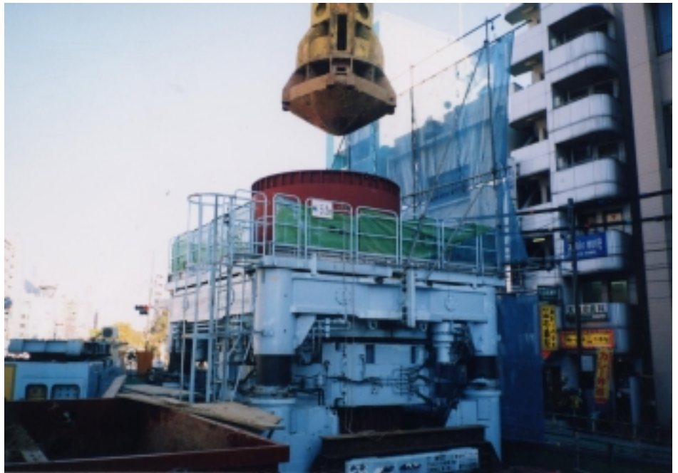
写真 - 1 施工状況図
