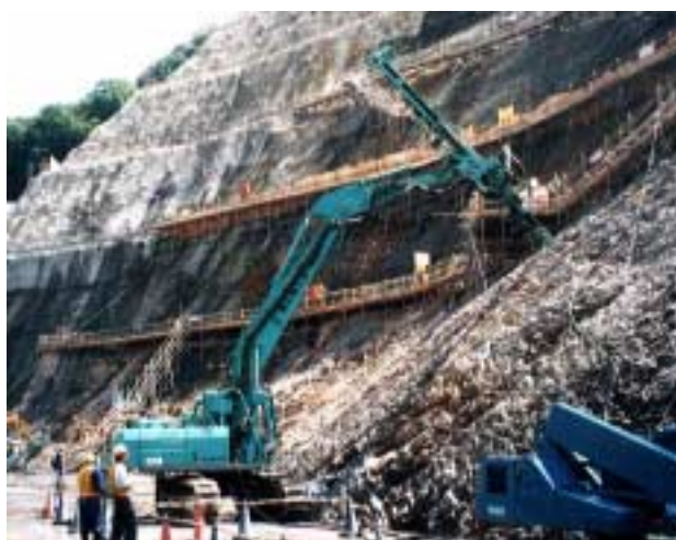
写真-1 「キツツキ」施工状況
