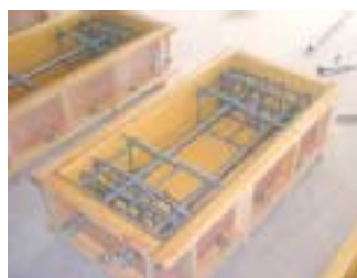
写真-1. 供試体配筋状況
