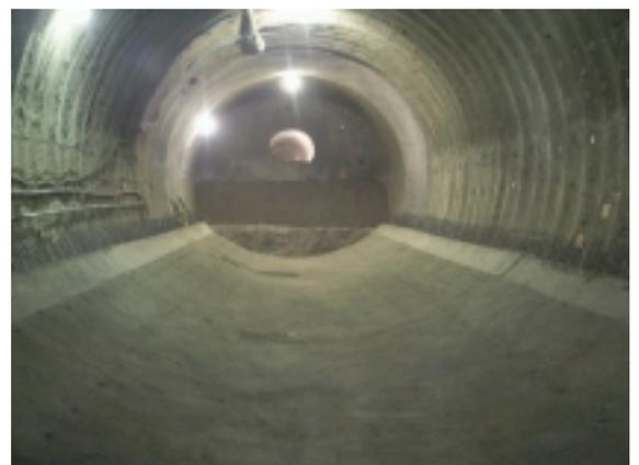
写真-1 インバートコンクリート全景
