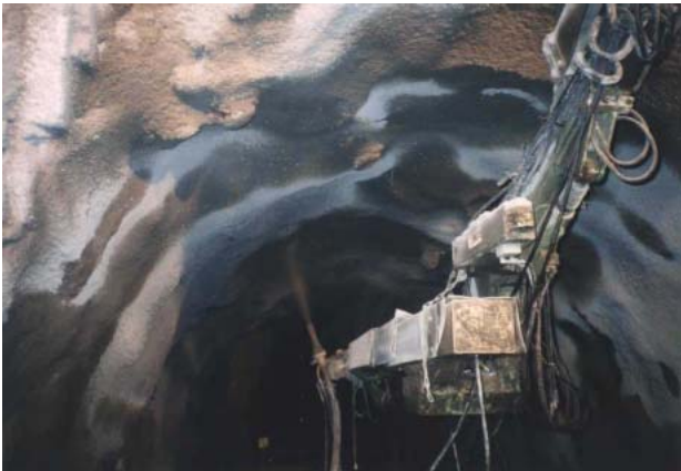
写真-1 液体システムによる吹付け状況
