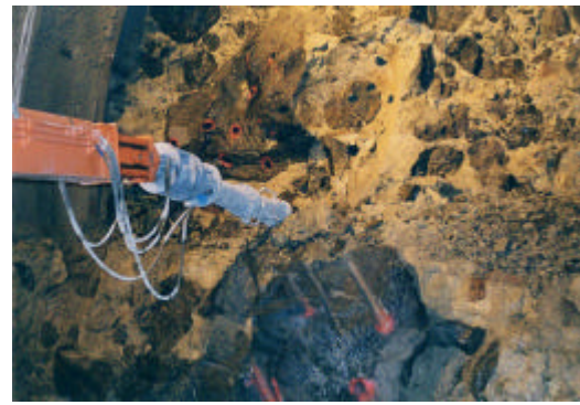
写真-2 硬質礫の割岩状況
