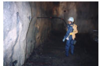
写真-2 実現した遠隔装填作業
