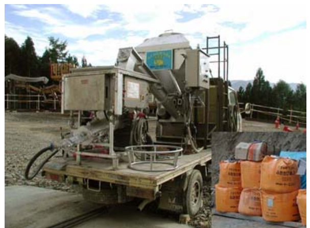
写真—3 モルタル注入台車
