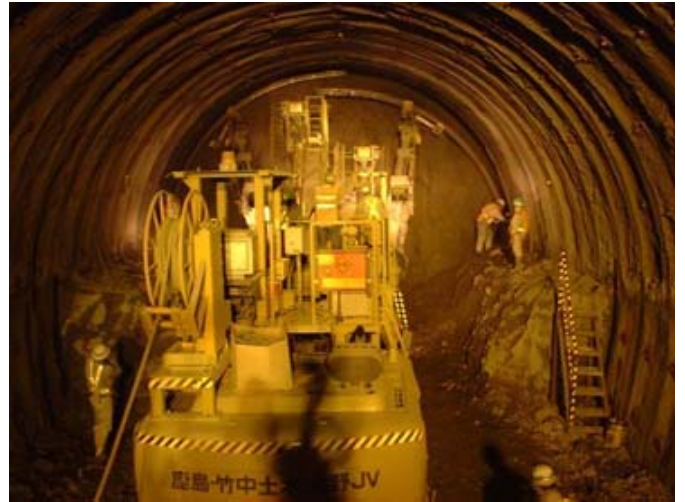
写真—1 支保工建込み状況
