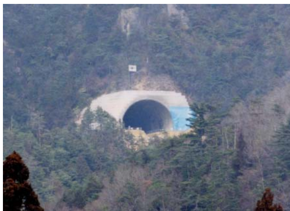
写真-1 坑口部施工完了状況
