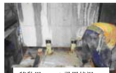
移動用レール設置状況
