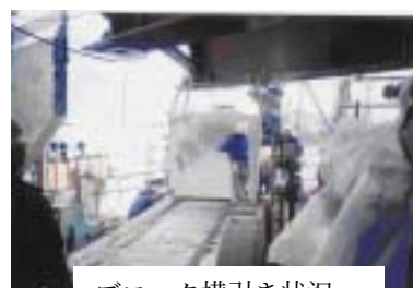
ブロック横引き状況
