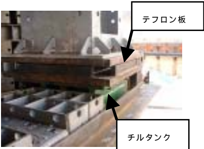
図-5 横移動ジャッキ構造
