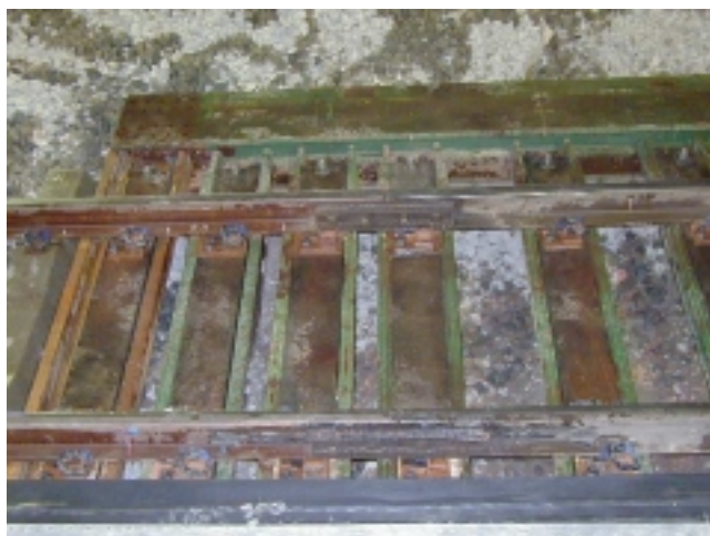
図 - 4 一括架設完了
