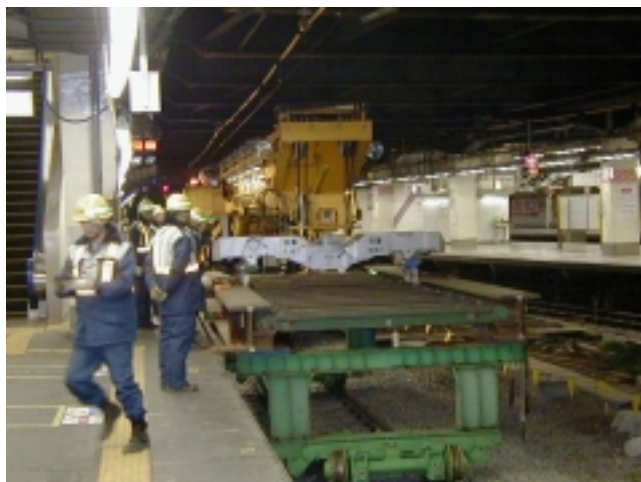
図 - 2 鉄道クレーンによる工事桁の移動状況
