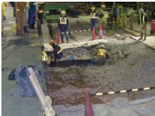
図 - 1 工事桁一括架設部の掘削状況
