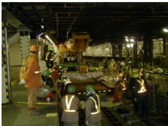
図 - 3 工事桁の一括架設状況
