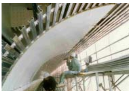
写真- 3 外装板施工状況
