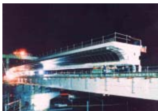
写真- 4 門司港駅構内清滝西海岸跨線橋
