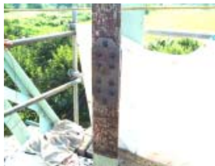
写真 - 3 ボルト継手
