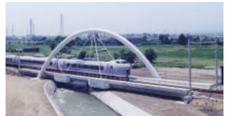
写真-1 除沢川橋りょうの写真
