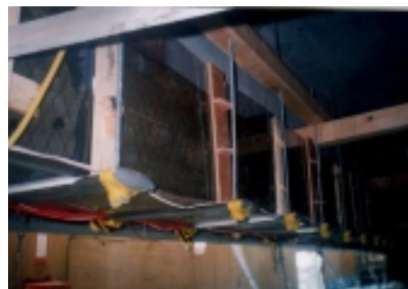
写真-1 電気化学的脱塩の状況
