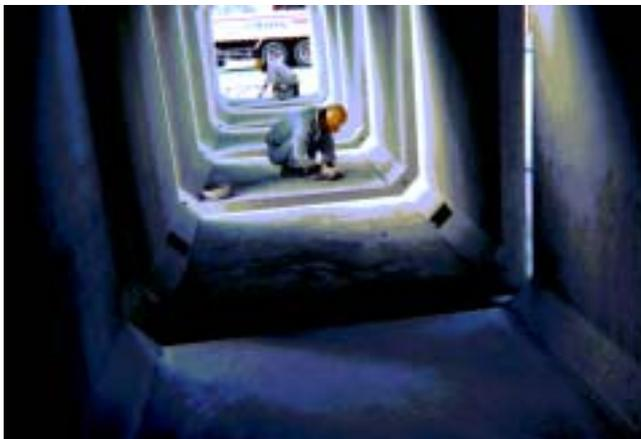
写真 2 コンクリート二次製品の補修
