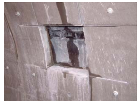
写真-2 充填状況の確認
