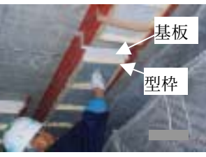
図-4 試験体の設置状況(天井面)
