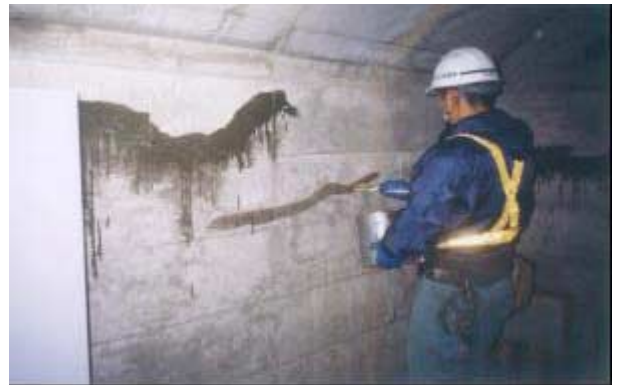
写真 ひび割れ浸透接着用樹脂塗布工の試験施工
