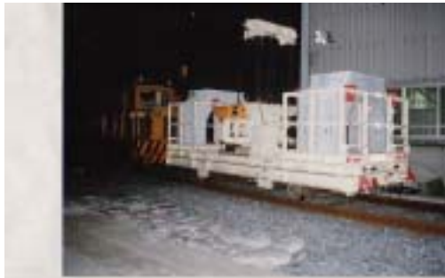
補強枠運搬（写真一３）
