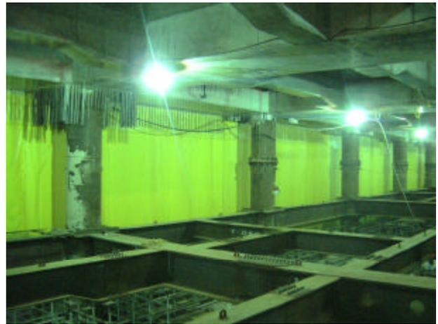
写真1 防水シート施工完了状況
