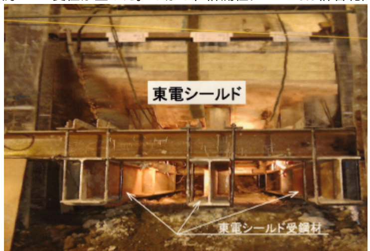
写真-1 東京電力シールド受け防護状況
