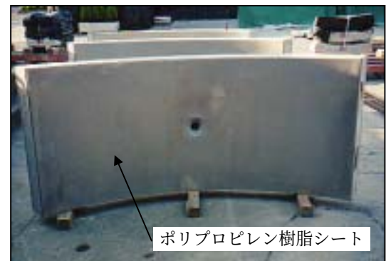
写真-1 ポリプロピレン樹脂シート 内面被覆 RC セグメント
