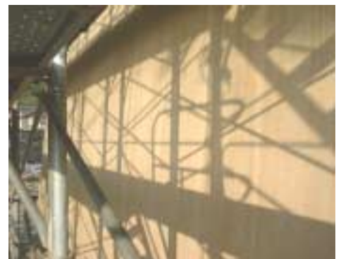
写真—2 型枠脱型後状況
