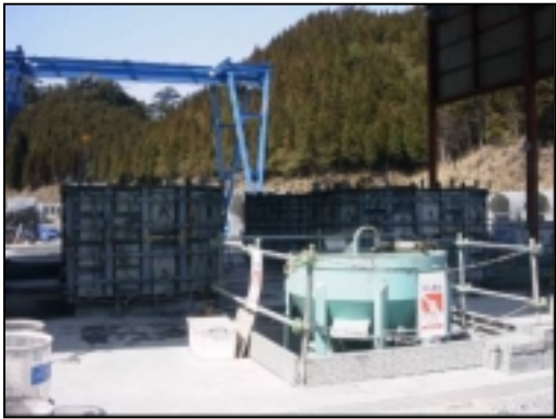
写真－1 現場プレキャスト工場写真
