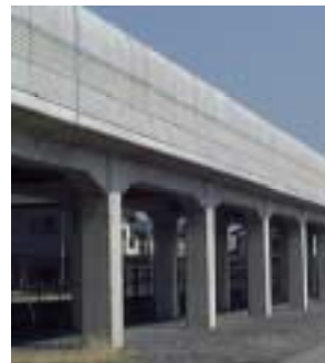
写真-1 ラーメン高架橋の外観
