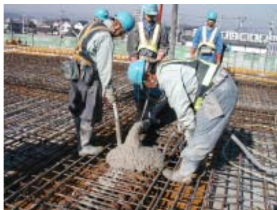
図 - 7 打設状況（横梁 高流動コンクリート）
