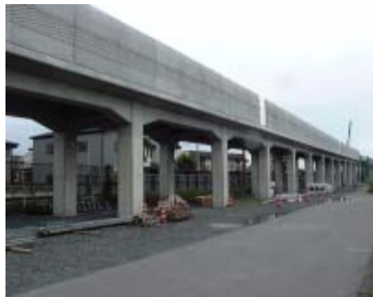
図-1 JR 両毛線栃木駅付近高架橋
