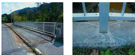
写真-1 S橋地覆の現況写真
