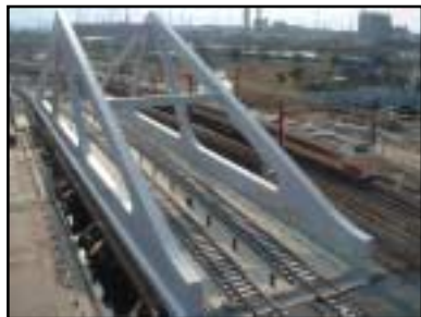
写真-1 姉ヶ崎川橋りょう
