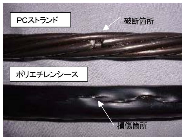
写真－１ 素線破断と被覆損傷状況
