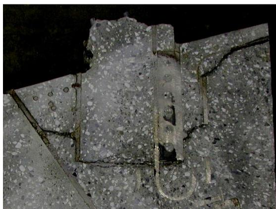
写真-1 内部ひび割れ状況
