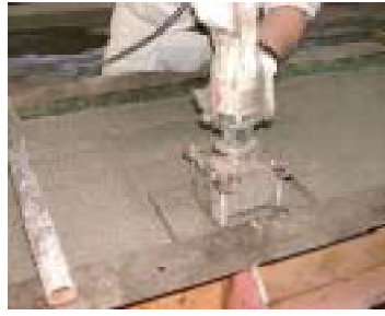
写真-2 骨材浮上り防止道具
