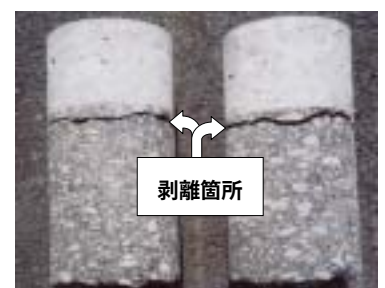
写真-1 隅角部の剥離断面
