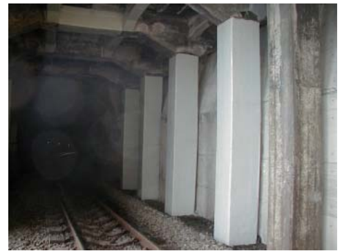
写真－4 施工完了状況
