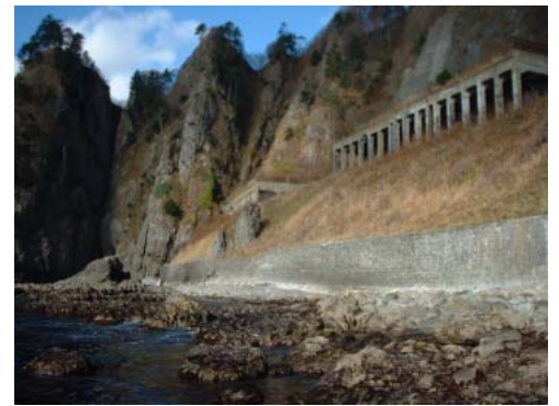
写真-1 落石覆いの外観
