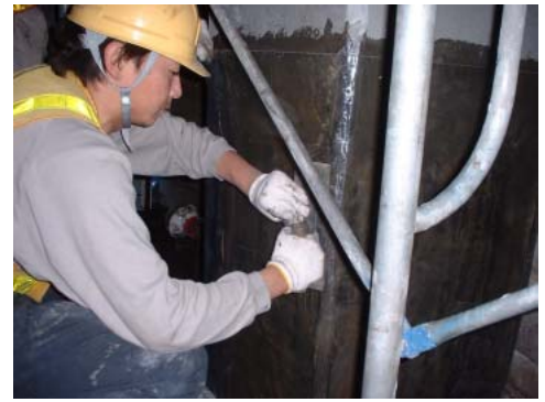
写真－3 タフシートの施工状況
