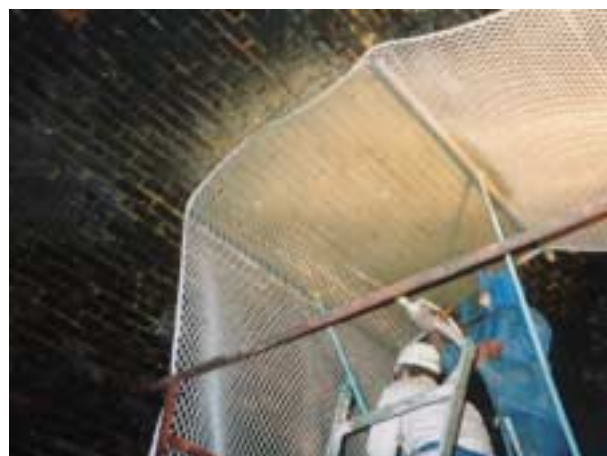
写真-1 SANショット施工状況
