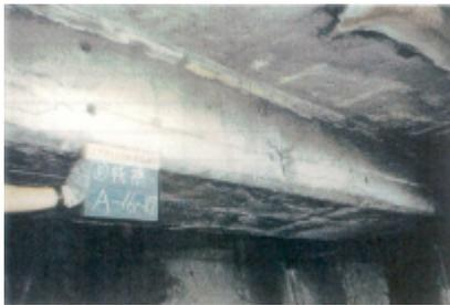
写真1 加速期後期の塩害劣化例
