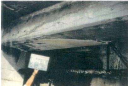
写真2 劣化期の塩害劣化例
