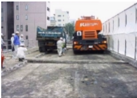
写真-1 舗装撤去後の実橋載荷試験
