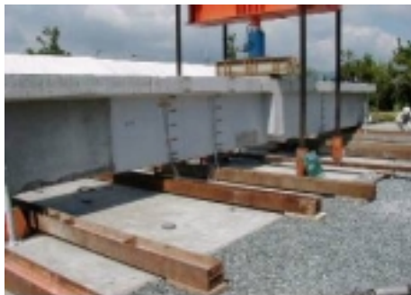
写真-2 補強撤去後の解体桁載荷試験
