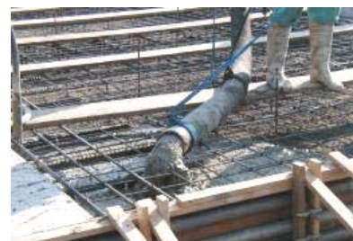
写真3 舗装コンクリート圧送状況
