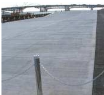
写真1 舗装コンクリート
