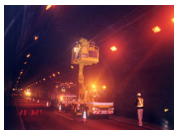
写真-1 Kトンネル(5 測線)
