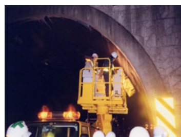
写真-3 Tトンネル(10 測線)
