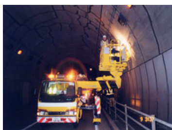
写真-2 Oトンネル(7 測線)
