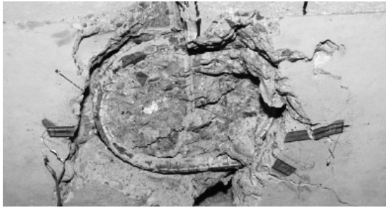
写真-1 SP-1の破壊写真
