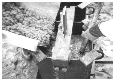
写真－1 コンクリート打設状況
