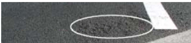
写真-3 実道における骨材飛散状況
