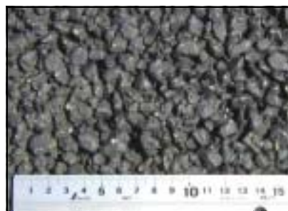
写真-2 再生排水性舗装表面（4ヶ月経過）
